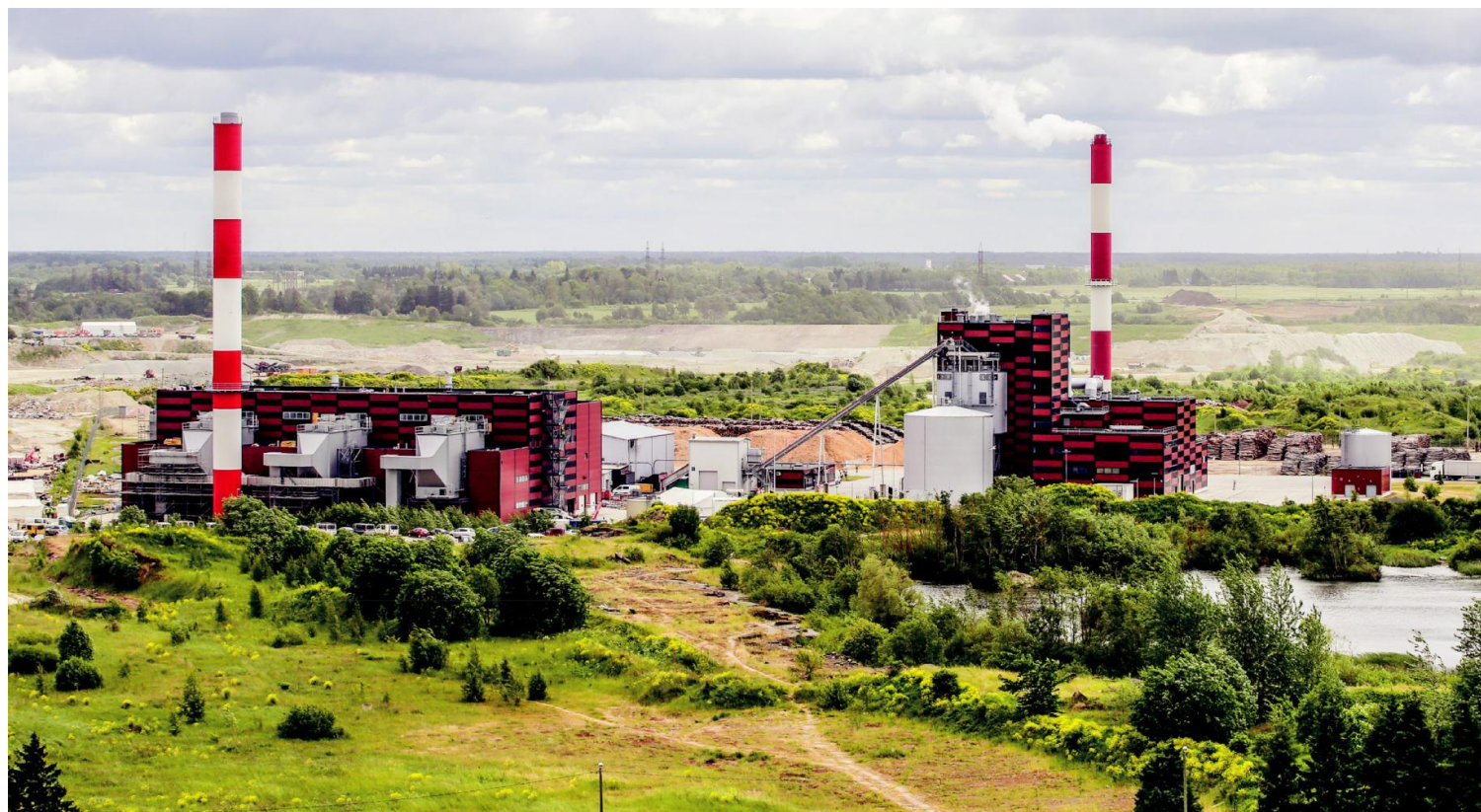
OÜ Utilitas Tallinna Elektri jaam two cogeneration plants
